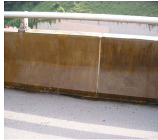
작업 전 상태
