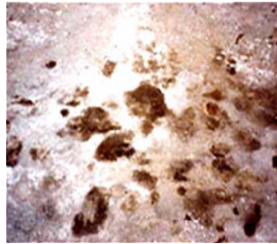
작업 전 상태
